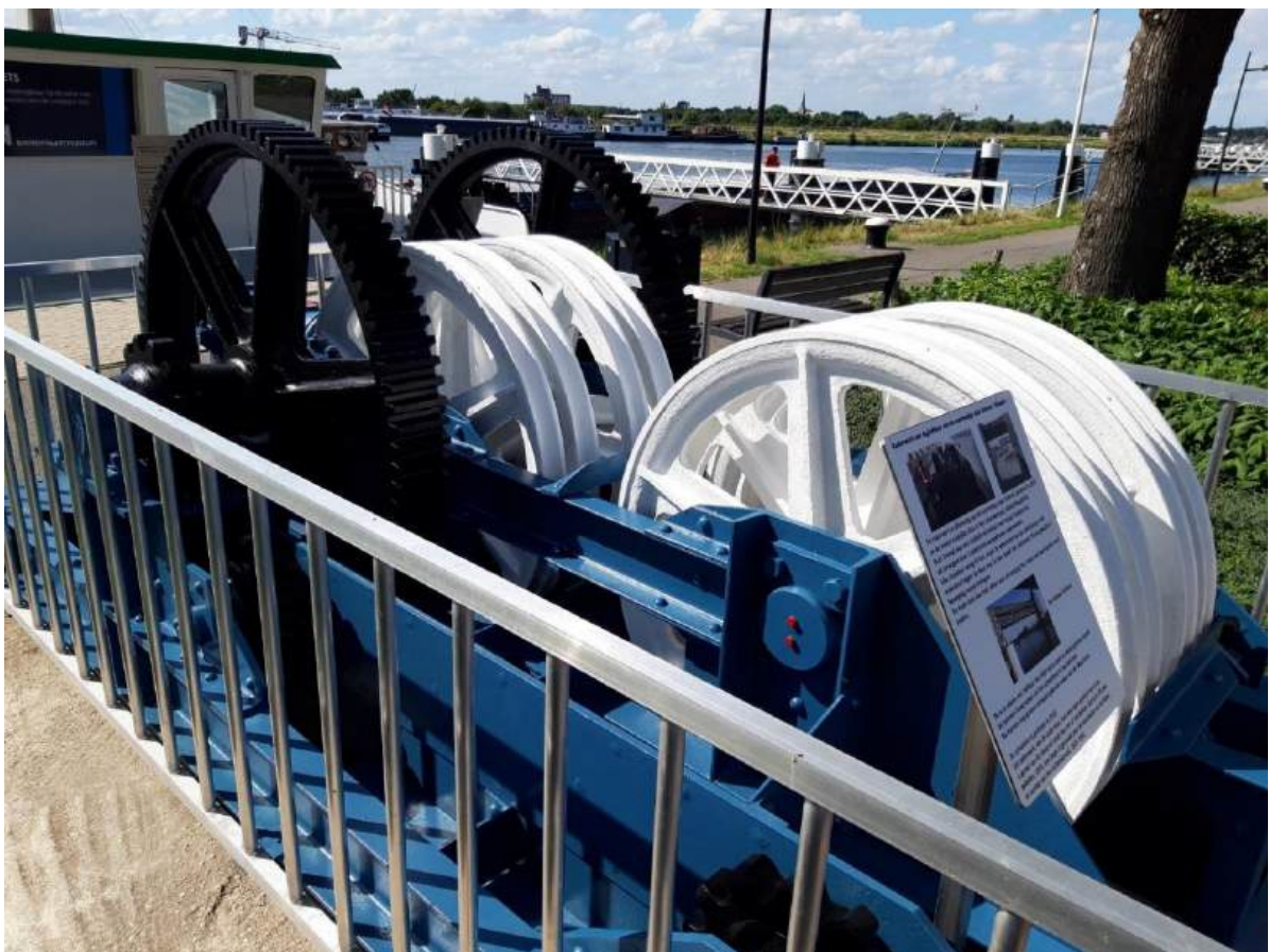
Raderwerk Sluis Limmel
